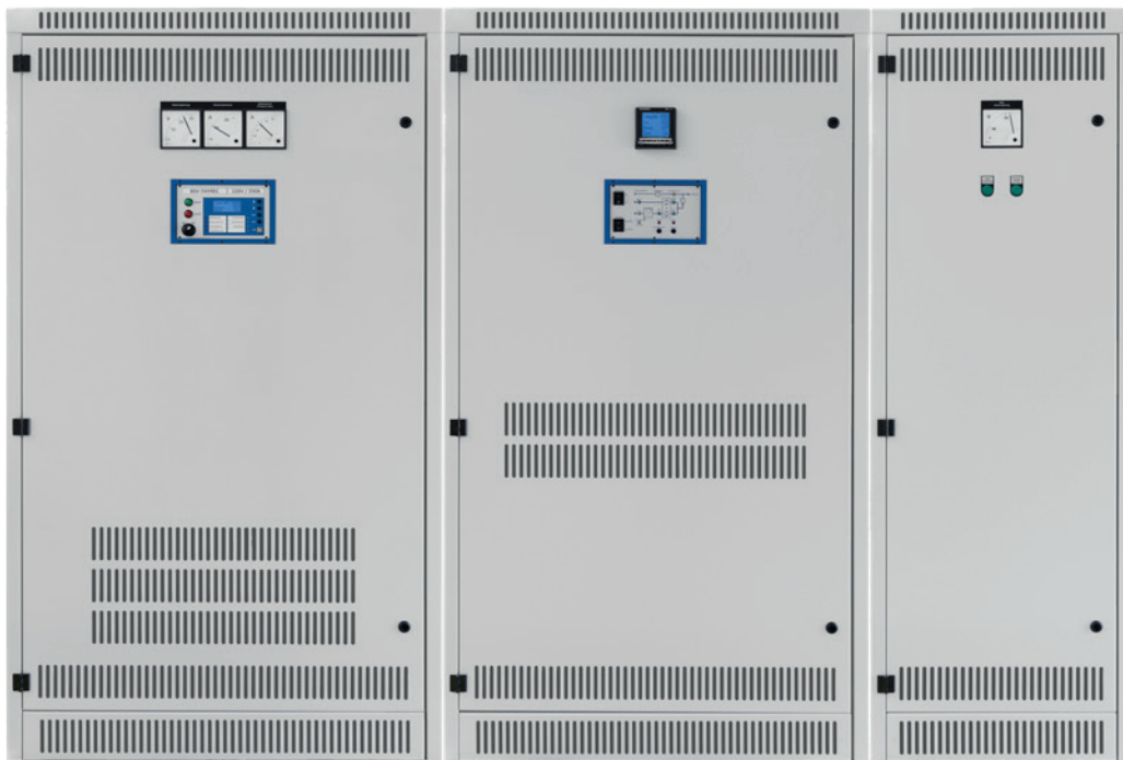
Beispielaufbau Schrank 1 (Wechselrichter), Schrank 2 (Gleichrichter), Schrank 3 (Bypass)
